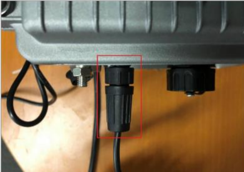
Instalación de conector energía
